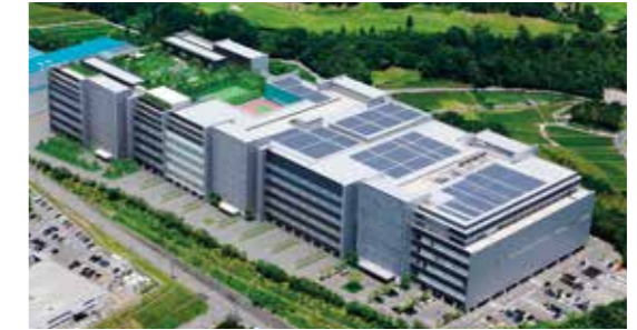
太陽光発電システム(桑畑工場)
