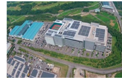
太陽光発電システム(桑畑工場)
